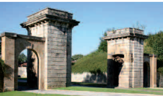
Porte nord (Photo P. Thomas)
