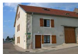
GITE « LE PASSAGE » - N°1044 *** Chemin de Chirey 52260 FAVEROLLES Tel : 03 25 30 39 08 (Service réservation)
