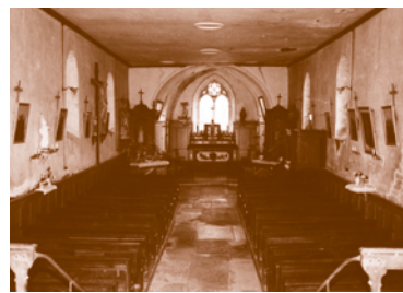
La nef et le chœur avant restauration
